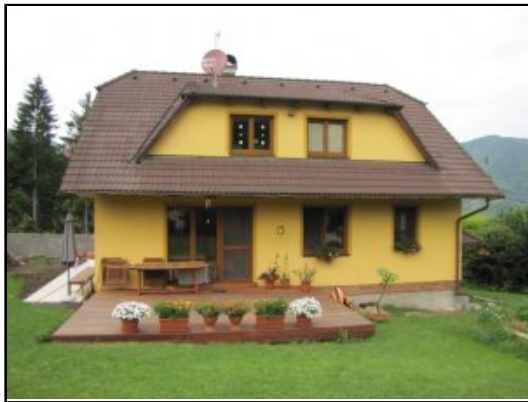
Pohľad na dom
